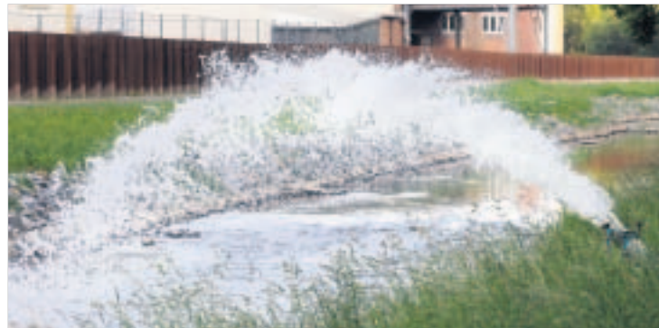
5 000 Liter pro Sekunde fördert die Pumpe. Der Druck reicht, um bei Bombardier eine Fontäne quer über die Spree zu schießen.
